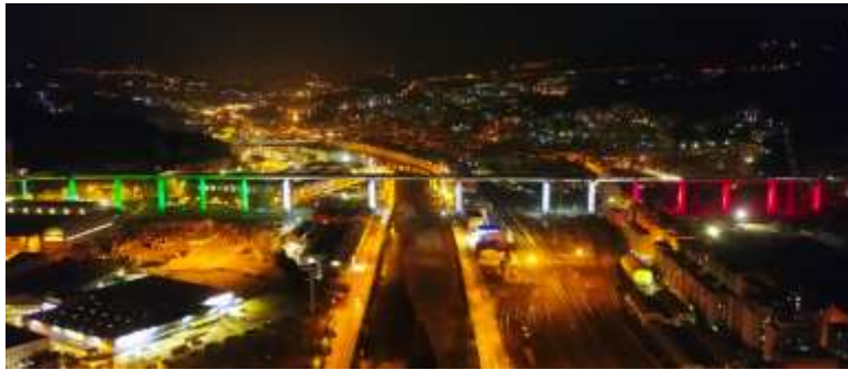
Ponte «Per Genova»
