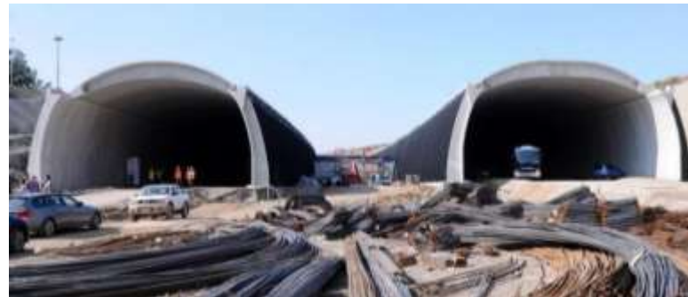
Autostrada Pedemontana Lombarda
