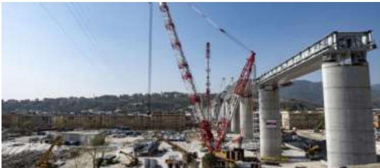
Ponte «Per Genova»
